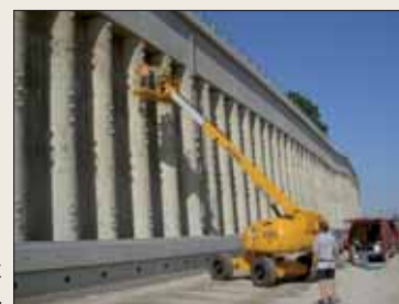
Ein Stützbauwerk aus Beton.
