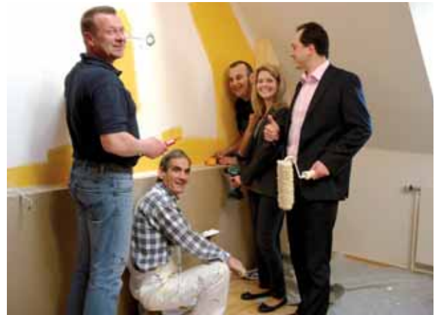
Renovierung. Mit vereinten Kräften wird im Schloss Mondsee mit der Neugestaltung der Zimmer begonnen.
