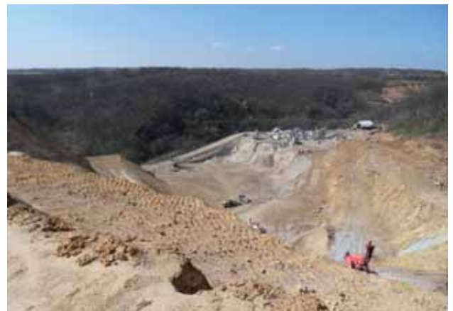
BMG. Blick von oben auf die Aufbereitungsanlage in Surduc.
