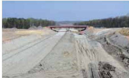
Baustelle. A1 Alpine
